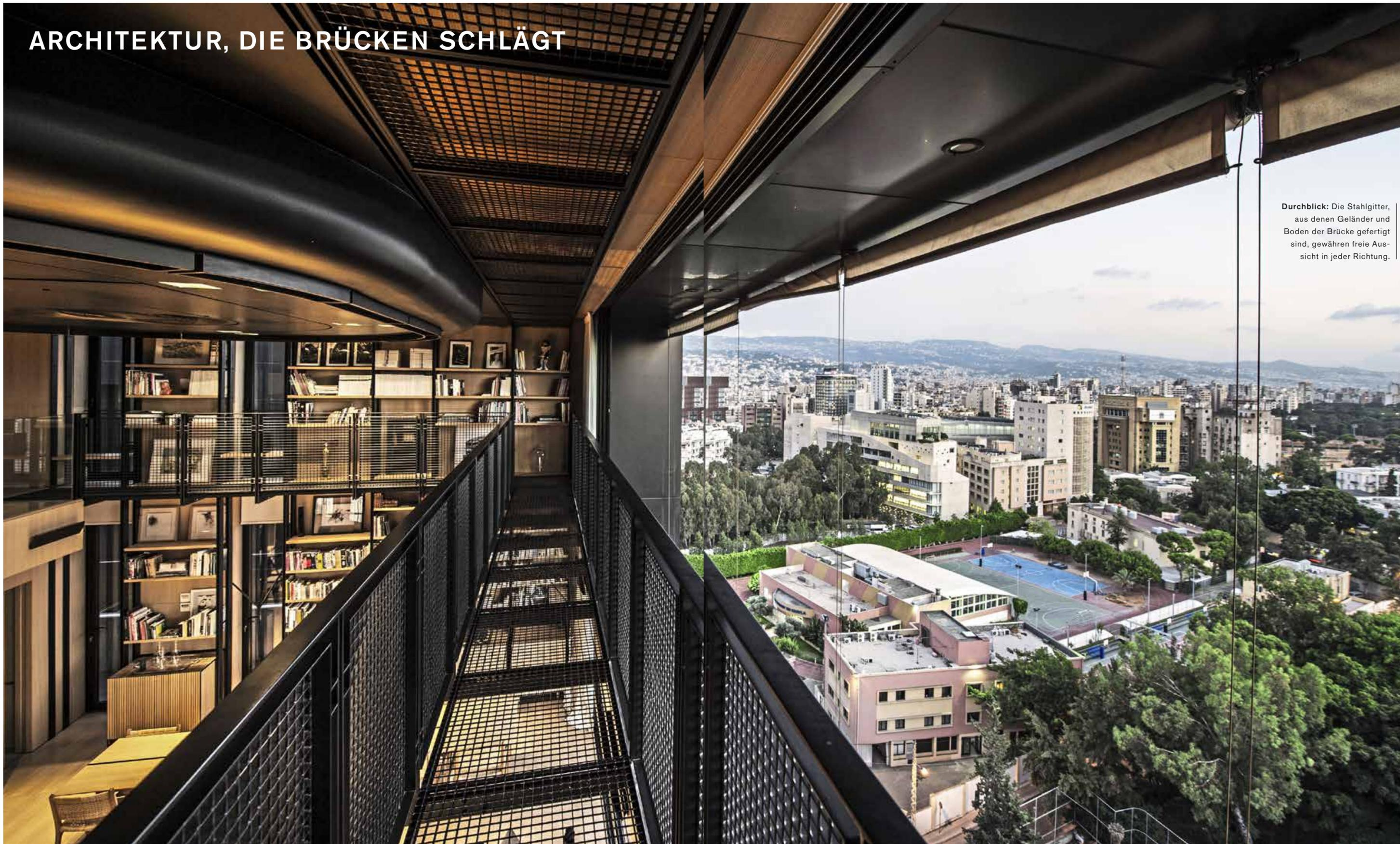
**Durchblick:** Die Stahlgitter, aus denen Geländer und Boden der Brücke gefertigt sind, gewähren freie Aussicht in jeder Richtung.
